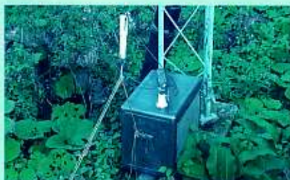
De antennetuner aan de voet van de 'folded monopole' antenne
